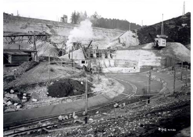
Baustelle für den Entlastungskanal bei Rausching, 1922. (Verbund Innkraftwerke GmbH, Töging)
