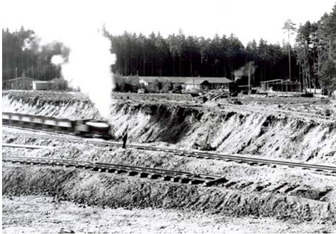
Die Kanalbaustelle bei Rausching, im Kanalbett eine Lok mit Loren, im Hintergrund die Baracken der Arbeiter, 1921. (Verbund Innkraftwerke GmbH, Töging)
