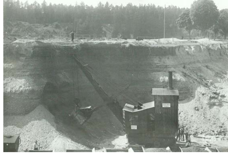
Baugrube für das Fundament der Kanalbrücke bei Pürten, Juli 1921. (Verbund Innkraftwerke GmbH, Töging)
