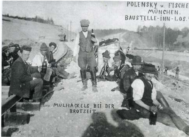
Arbeiter bei der Brotzeit auf der Kanalbaustelle, um 1922.
