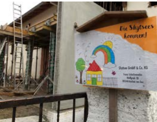
Bei den Shytsees ist alles etwas anders - und immer besonders! Sogar die »Bautafel«, die das neue Büro ankündigte...
