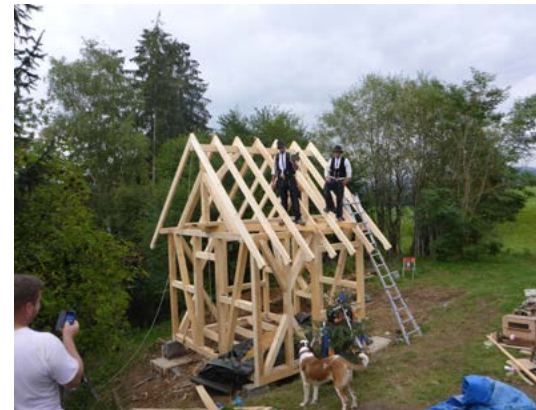
Das erste Richtfest - Fachwerkbienenhaus im Allgäu
