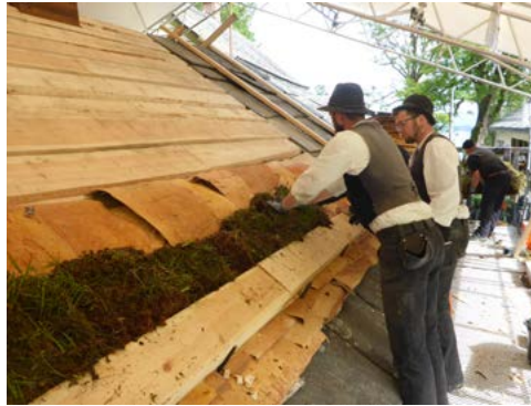
Oben: Torfdachdecken in Norwegen
