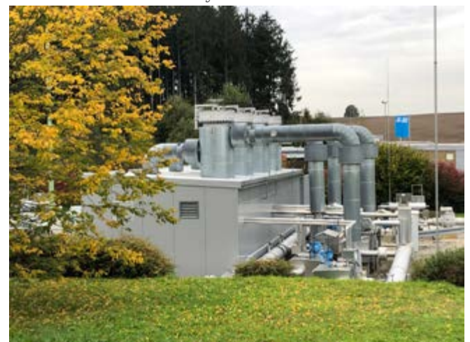
Ein Teil der Verfahrenstechnik ist der Wasserabscheider
