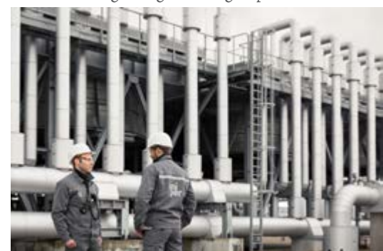
Gaskühlungsanlage des Erdgasspeichers
