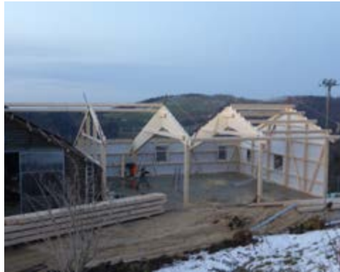
Baustelle im Jura in der Schweiz
