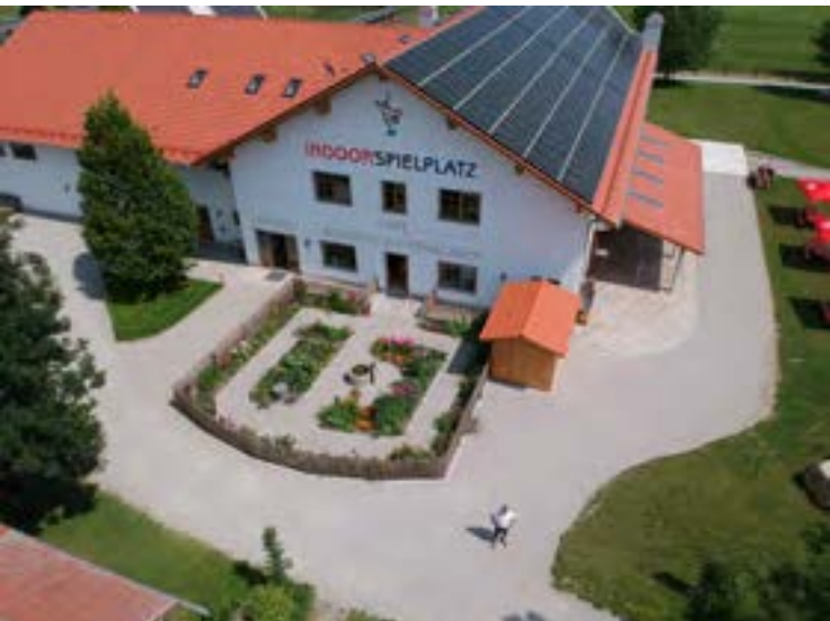
Komplett fertig gestellt ist jetzt die neue Indoorhalle mit Café samt Sonnenterrasse, Regionalladen mit großem Bauerngarten und Bahnhof für die Wildpark-Bahn
