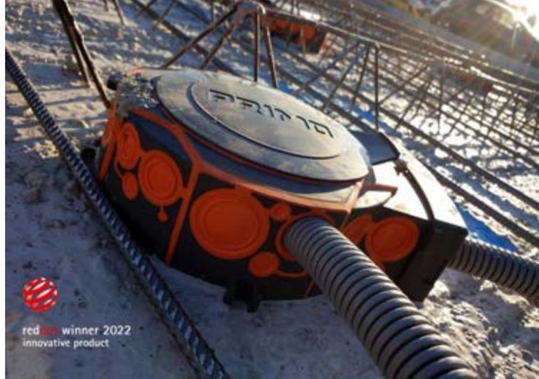
*Die Einbaugehäuse der Primo XL-Serie bekamen den Red Dot Award 2022. Die Auszeichnung bei einem der größten Design Wettbewerbe der Welt gilt als internationales Gütesiegel. Hier die XL-Serie im Einsatz auf der Beton-Baustelle. Die Einführung aus Membran umschließt das Rohr komplett und sorgt für den absolut betondichten Abschluss.*
