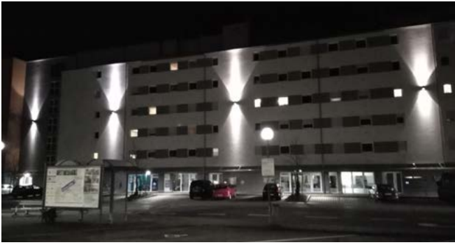
Nach oben gerichtete grelle Fassadenbeleuchtung- Foto: Margit Seifert
