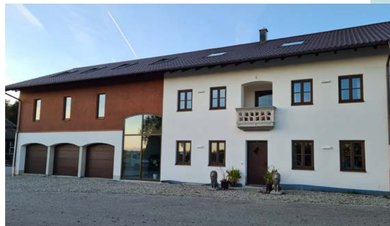
Ursprüngliche Kommunionbank aus einer Kirchensanierung als Balkon.
